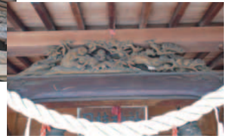
写真2 拝殿の向拝（彫刻）
