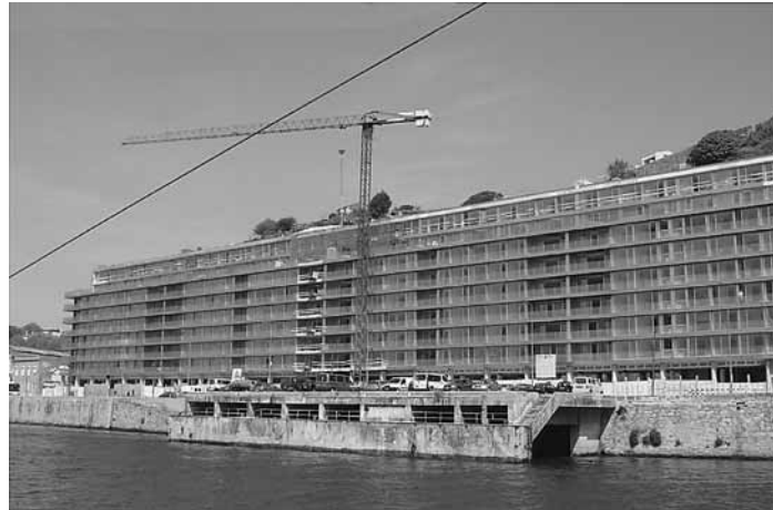
写真8 ポルト市街における建築工事の状況
