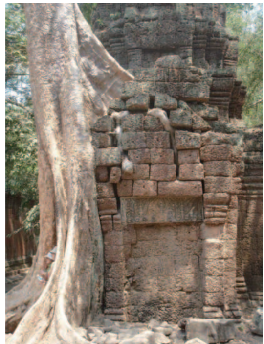
写真4 アンコール遺跡タ・プロムの組石造の根の肥大による破壊
