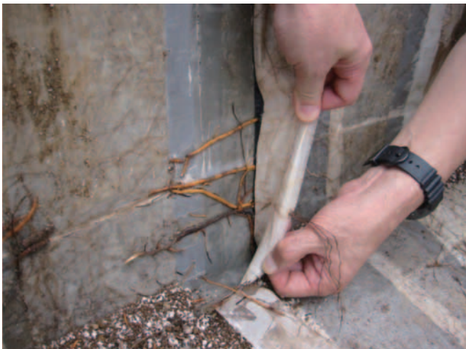
写真2 シートのジョイント部への地下茎や根の侵入(一部剥がして撮影)
