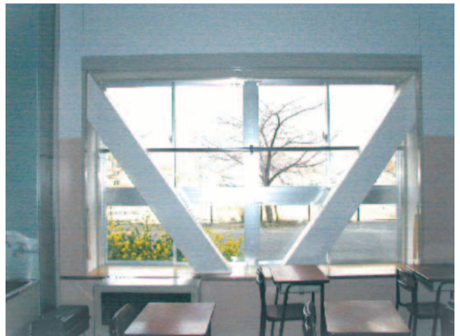
写真1 枠付き鉄骨ブレース補強
