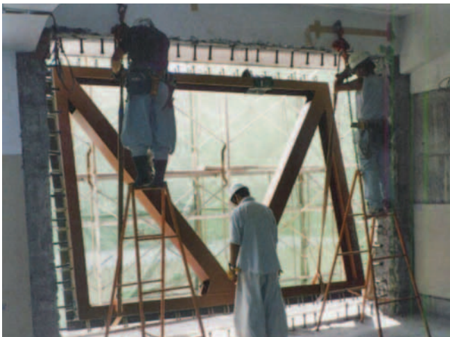
写真1 枠付き鉄骨ブレース補強
