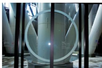
足元には、直径2.3m、板厚100mmという巨大な鋼管が使用されています。2年前、部材の製作現場を見学した際、巨大鋼管の断面や継ぎ手の溶接部の迫力に目が釘付けになったことを今でも覚えています。
