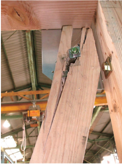
写真4 破壊状況、筋かいの割裂 (試験体記号: BP2)
