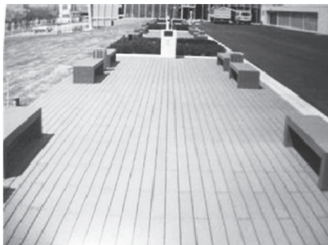
写真1 ウッドデッキ施工例
