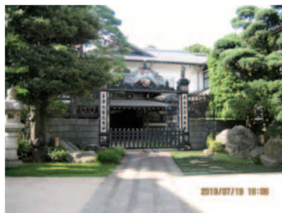
図3 妙法寺の鉄門(左) 製造の印「明治十一年 工部省工作分局 東京赤羽」、(中) 全景、(右) 門扉 門幅4.3m(門柱真々)、全高4.96m(中央門飾り上端まで) (所在：妙法寺 東京都杉並区堀ノ内3丁目48-8)
