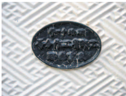
図3 妙法寺の鉄門(左) 製造の印「明治十一年 工部省工作分局 東京赤羽」、(中) 全景、(右) 門扉 門幅4.3m(門柱真々)、全高4.96m(中央門飾り上端まで) (所在：妙法寺 東京都杉並区堀ノ内3丁目48-8)
