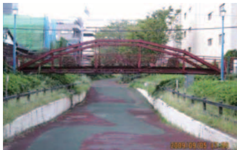
図4 八幡橋(元弾正橋)(左) 菊の御紋、(中)(右) 全景 現在：橋長15.2m、橋幅2m、架橋時：橋長8間2尺(約15.2m) 橋幅5間(約9.1m)。 (所在：移設後 東京都江東区富岡1丁目19～2丁目7、移設前 東京都中央区京橋2・3丁目～八丁堀3・4丁目)
