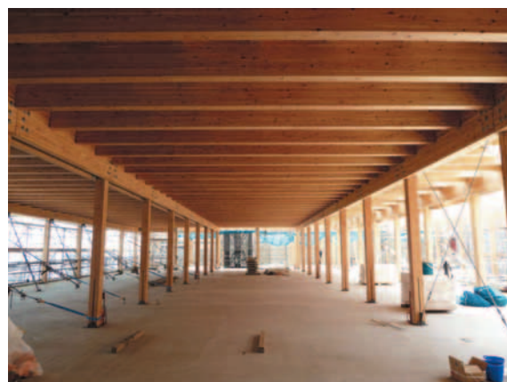
図3 梁配置 (施工中)
