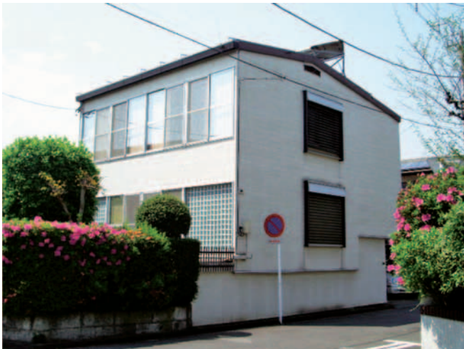
写真 2005年に南面を改修した木村ソーラーハウス
