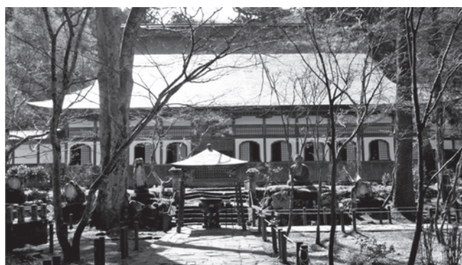
写真1 本堂(間口14間, 奥行き10間半/25.2×18.4m)
