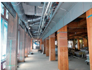
写真8 1,2階下がり天井内部
