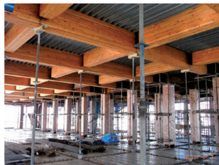
写真14 スラブ打込み前
