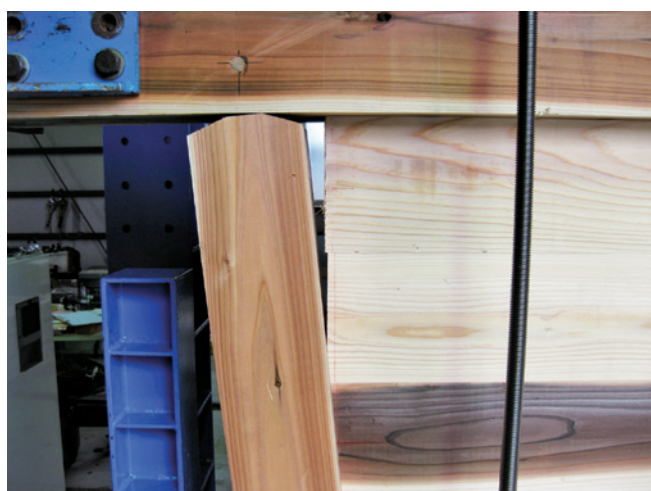
写真3 損傷状況(落とし込板壁:隅角部)
