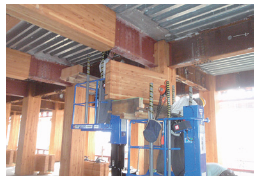
写真11 カバー材取付工事
