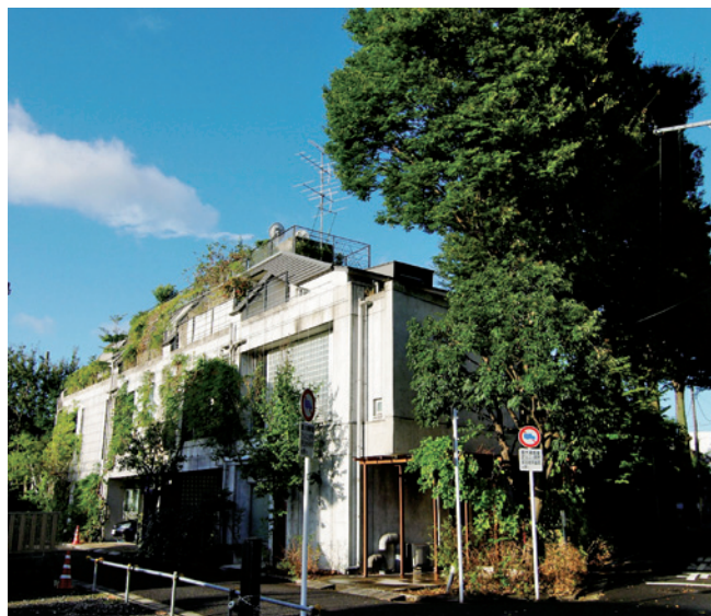
筆者が住むスケルトン・インフィル方式によるコーポラティブ住宅「経堂の杜」。2000年建設。階高は床下を含め3300mm。外断熱工法を採用している。（コーディネート：㈱チームネット）
