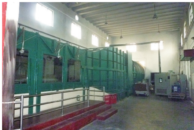
写真6 燃燒風洞の外観
