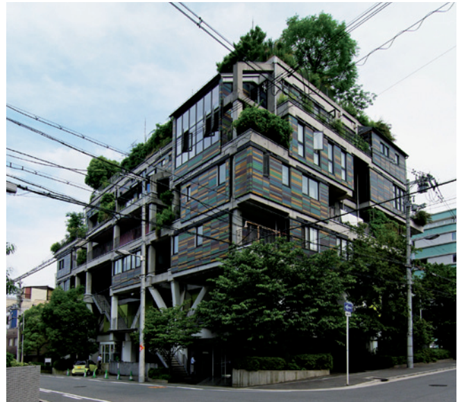
㈱大阪ガスが実験住宅として建設したスケルトン・インフィル方式の「NEXT21」(1993年)。有志社員の社宅として居住実験が行われており、2007年より「第3フェーズ」(写真は全て筆者)に。フェーズ毎に居住者の入れ替え・内装や設備変更の実証実験も行っている。
