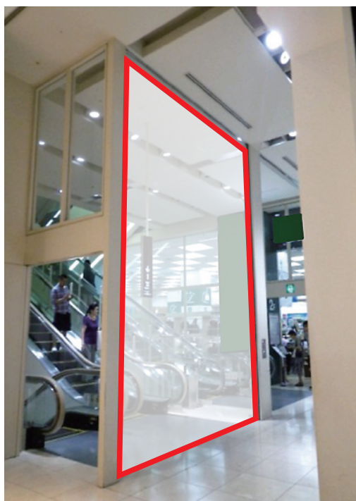
写真1 堅穴区画部における鋼製シャッター （非常時は赤枠部がシャッターで閉鎖される）
