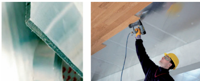
図4 潜熱蓄熱体封入壁部材の例(アメリカ デュポン社) 日本でも石膏ボードや床仕上げ材の開発が進められている
