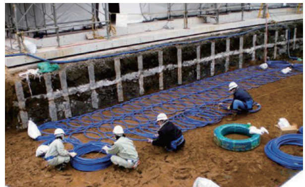
写真2 水平埋設による地中熱利用(採熱側施工中)
