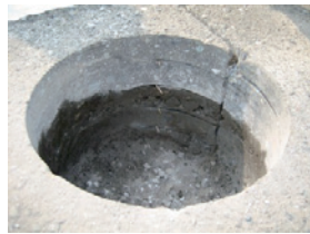
写真3-2 道路掘削状況
