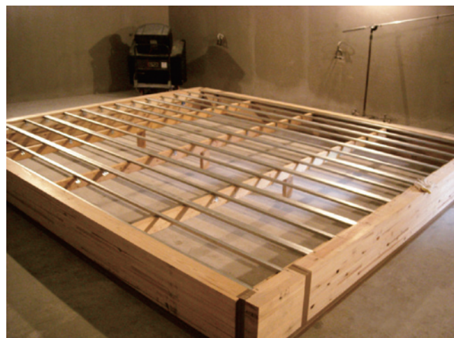
写真1 背後空気層の施工例
