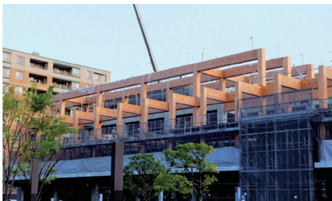
図13 サウスウッド (耐火集成木材建て方時)
