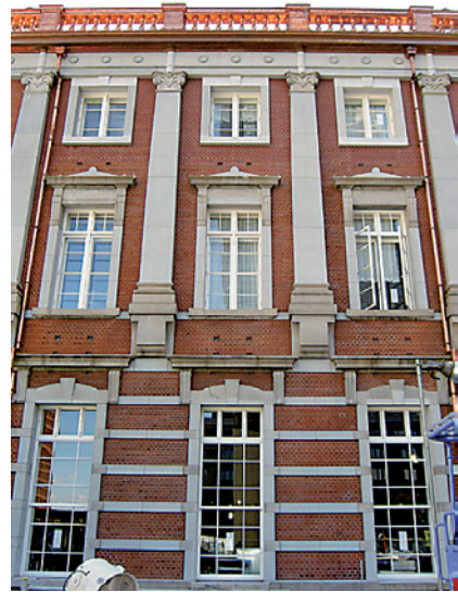
図2-2：復原部の完成した状況 **
