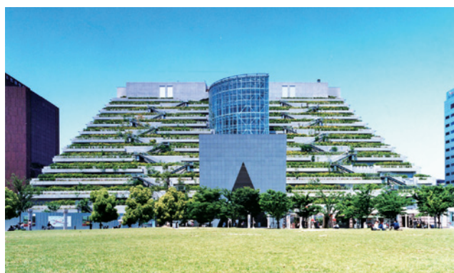
写真1 竣工時の外観
