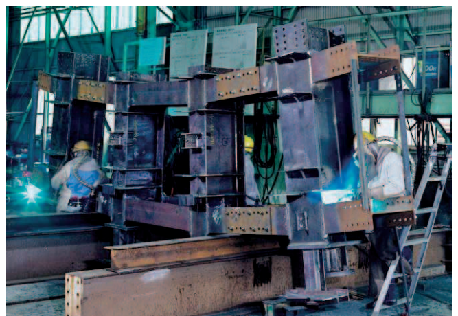
写真6 天望回廊～床梁の製作
