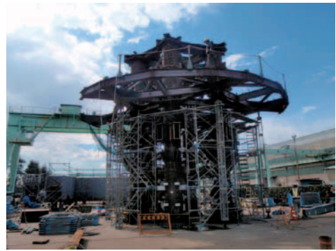
写真7 ゲイン塔G16節の仮組
