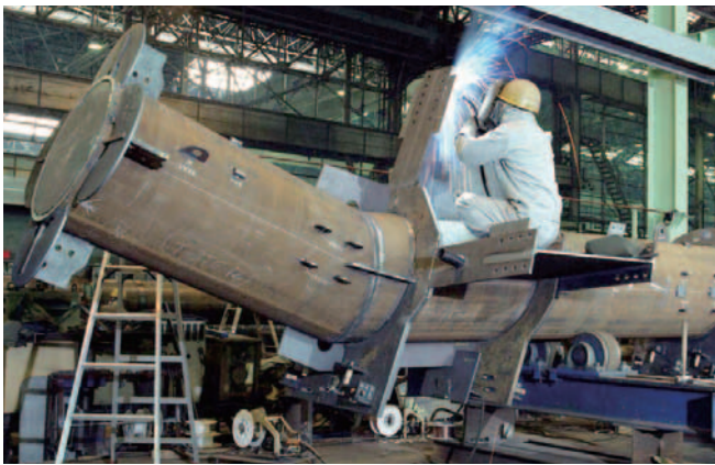
写真3 天望デッキ(水平梁外ダイヤフラム周辺)
