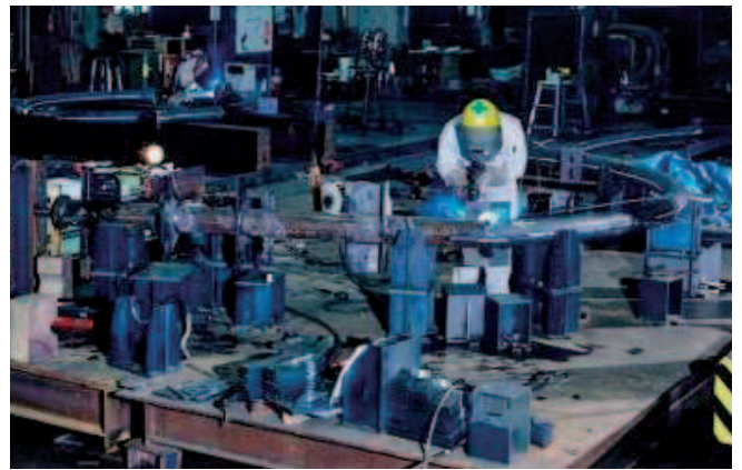
写真5 天望回廊～アーチ型鋼管柱の製作
