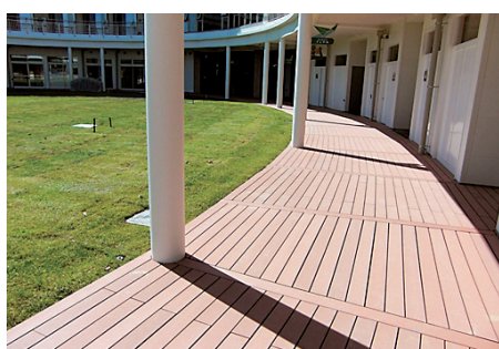
写真1 WPRCの施工例(デッキ) 1)
