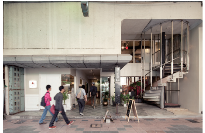
中屋ビルの木造部分を低コストで改修。ものづくりを中心としたテナントが入居し、メルカート三番街として甦った。2012年12月隣家の火災の類焼を受けたが、地域の支援の輪もあり復興。
