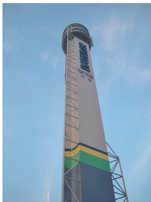
写真8 ヒュンダイエレベーター試験棟
