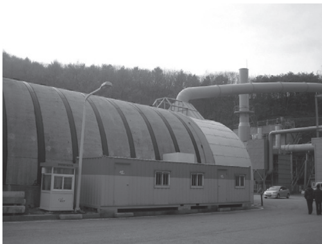
写真14 トンネル実験棟外観
