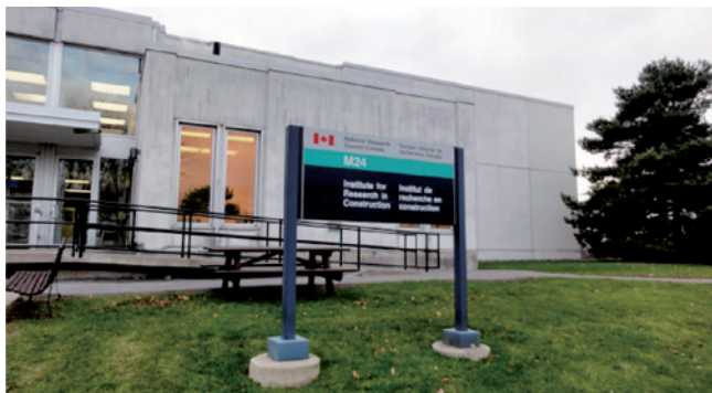
写真1 NRCの研究棟の外観
