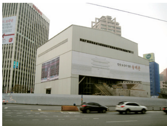
写真2 修復作業中の南大門 (城壁の一部のみ確認できる)
