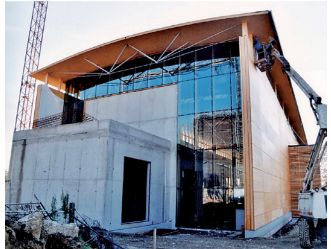
CLT 使用例 オーストリアグラーツ工科大学実験棟 工事中 (完成直前) 2000 年
