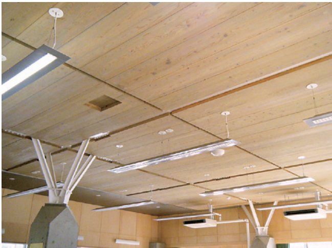
国産 CLT の使用例校舎 内部 天井
