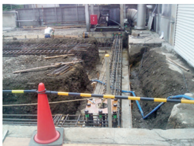
写真2 基礎工事① (2013.5.21)
