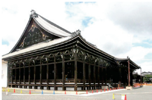
竣工正面側(南から)
