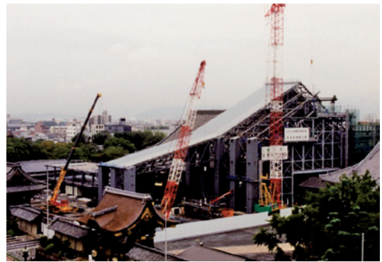
仮設工事素屋根建設
