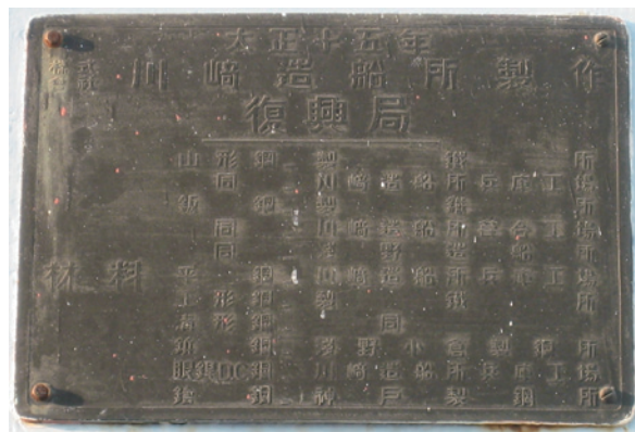
図3 永代橋に付けられた銘板 (下から2行目の「眼釘D.C鋼」とは「アイバーのデュコール鋼」)
