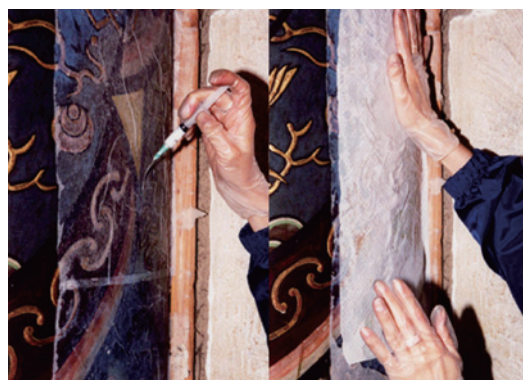
柱上部の彩色剥落止め作業
