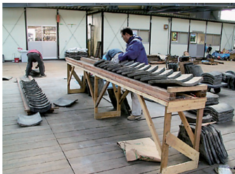
葺き上げ前の仮並べ作業
