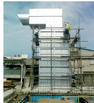
写真3 二次燃焼炉の組み立て (2013.6.7)
