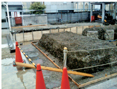
写真1 地盤処理と基礎工事準備 (2013.5.16)
