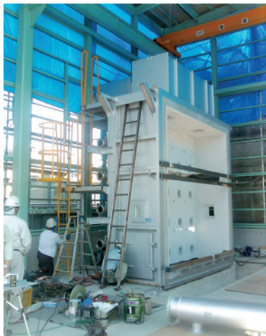
写真5 炉体設置, 組み立て (2013.7.7)
