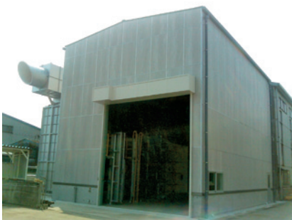
写真6 完成した試験棟
