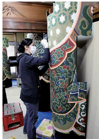
強化紙を覆い板として表層剥離した柱を保護すると共に復原彩色を描く
