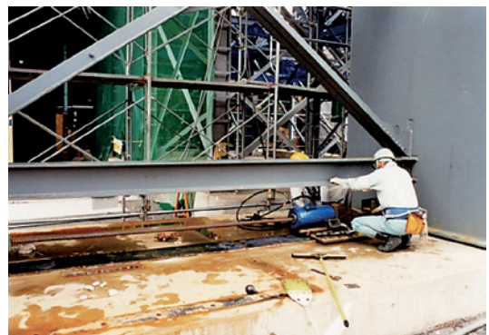
スライド工法による省力化作業
