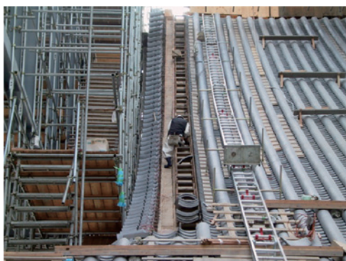
熟練した葺師による屋根瓦葺き
