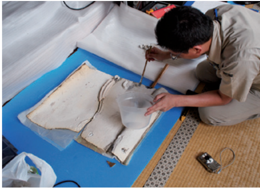
剥離部を裏打ちして再度取付
