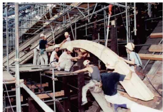
折損のため、取替えた「チョウナ桁」の取り付け作業
