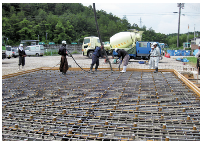
写真7 構造反力床の施工状況
