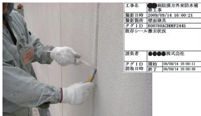
写真3 ICタグより入手した工程情報と写真画像とのリンクの結果
