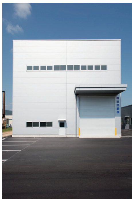
写真1 新構造試験棟の外観
