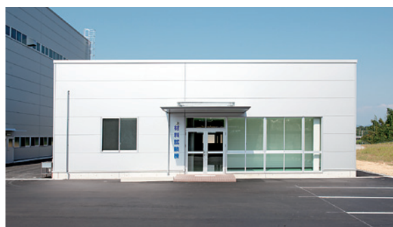
写真1 新材料試験棟の外観
