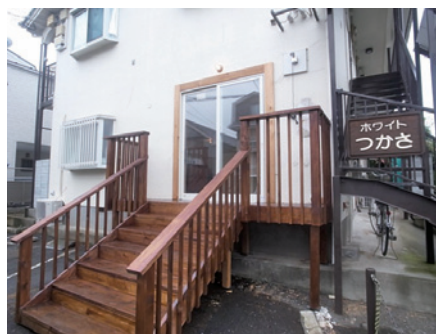
壁に新たに出入口を新設し、階段を取り付けた。裏側には、車いすもアクセス可能な出入口もある。
