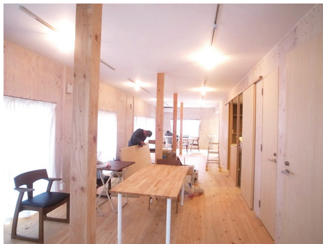
改修工事がほぼ終わったホワイトつかさ。3戸に分かれていた1階戸境の壁を取り払い、デイサービス施設に用途転用した。
