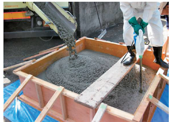
写真3 母材の作製状況
