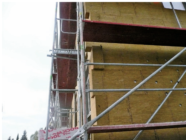
写真4 断熱材の厚さに注目
