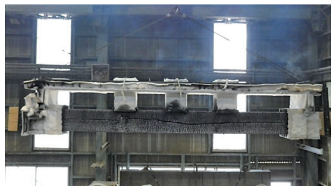
写真1 試験体の状況(試験体記号A1) (上: 試験前, 下: 試験後)
