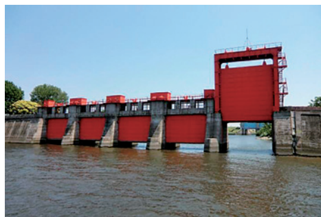
写真1 旧岩淵水門（赤水門）
