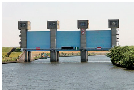
写真2 新岩淵水門（青水門）
