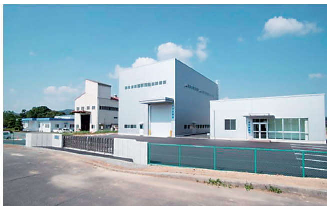
写真3 西日本試験所(右側の2棟が新試験棟)
