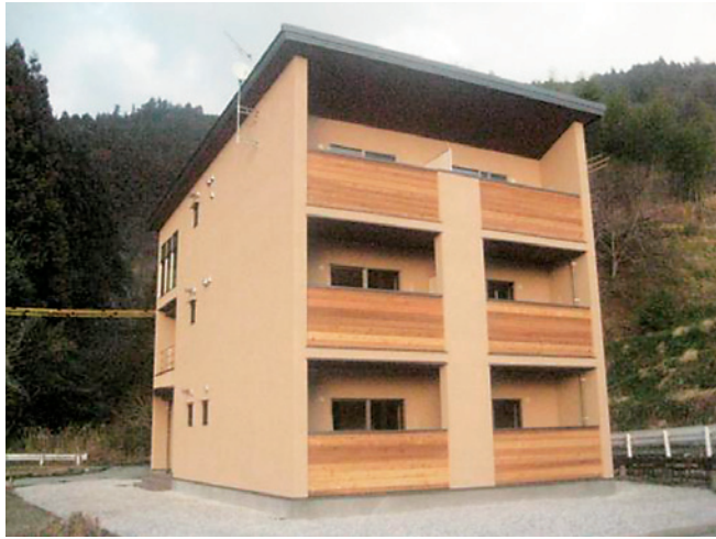
写真3 CLTを用いた共同住宅 (外観からは木造かどうかわからない)
