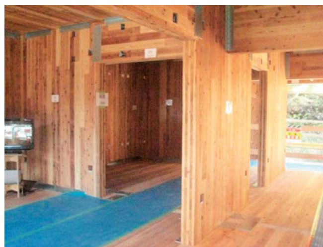
写真2 CLTの躯体による社宅の建設段階
