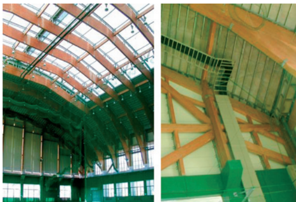
写真1 サンドーム日向(RC造に木造屋根構造) (ルートB設計)
