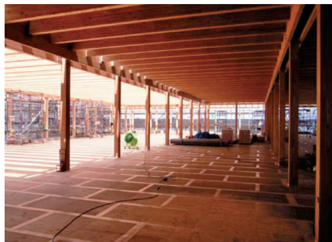
写真1 東部地域振興ふれあい拠点施設(耐火被覆前) (2011年/埼玉県)
