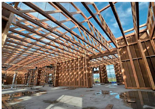
写真2 10m スパンのトラス梁を用いた工場(福井)
