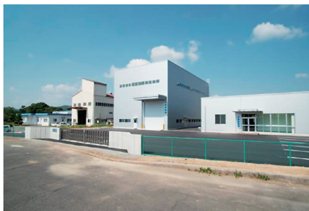
写真3 新構造試験棟・新材料試験棟の概観
