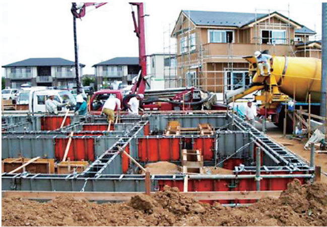
写真3 住宅基礎コンクリートの打設状況
