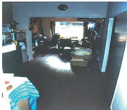
写真2 改修後のフローリング(オーク材)の床
