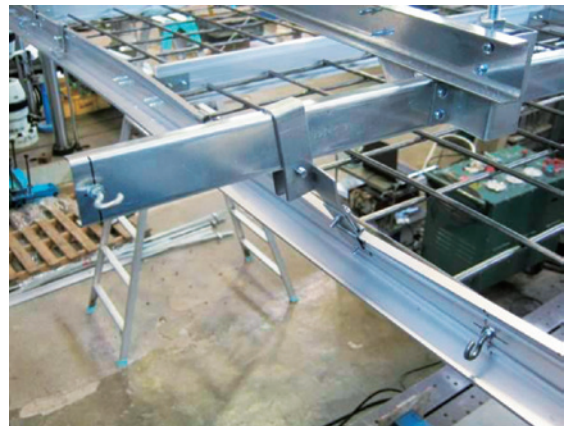
写真5 吊り金具の変形
