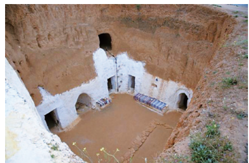
写真1 ヴァナキュラー建築の一例(日中の強い日射しと冬の寒さをしのぐための工夫がなされたチュニジアの穴居住宅「マトマタ」)
