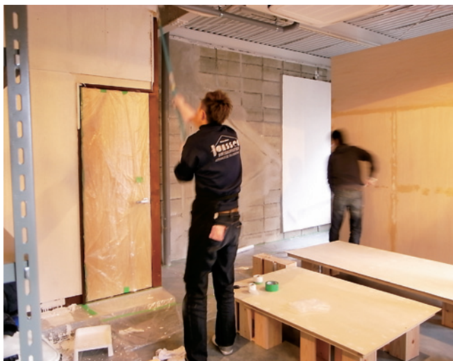
改修に当たって、企画段階に決まった入居者と壁塗装などのリノベーション工事を行った。(写真：スペースRデザイン)
