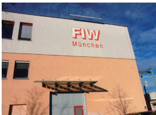
写真9 FIW (搬入口付近から)
