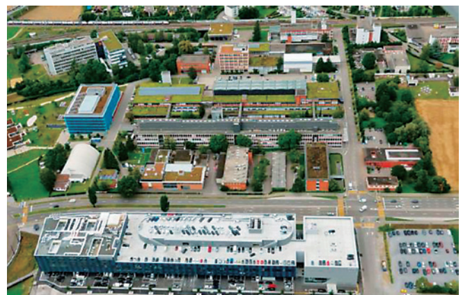
写真1 Empa Dübendorf 俯瞰 3)
