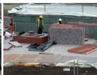
施工状況(その2)
