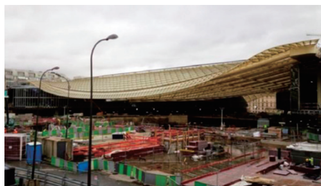
工事現場俯瞰
