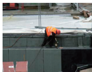
施工状況(その1)
