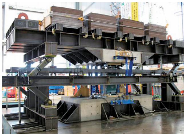
写真2 試験体設置状況
