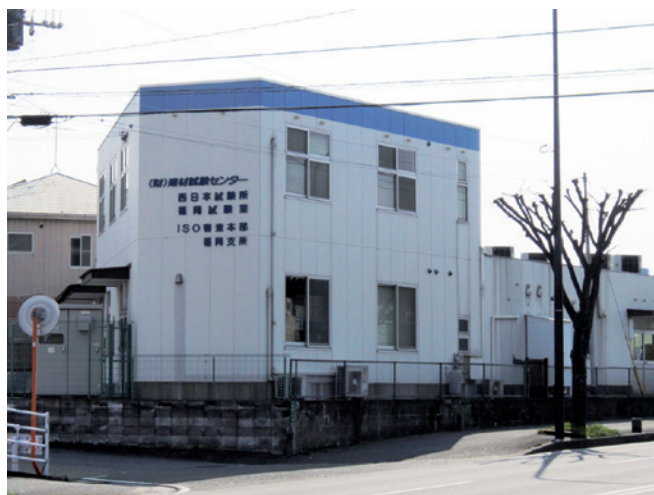
写真1 福岡試験室外観
