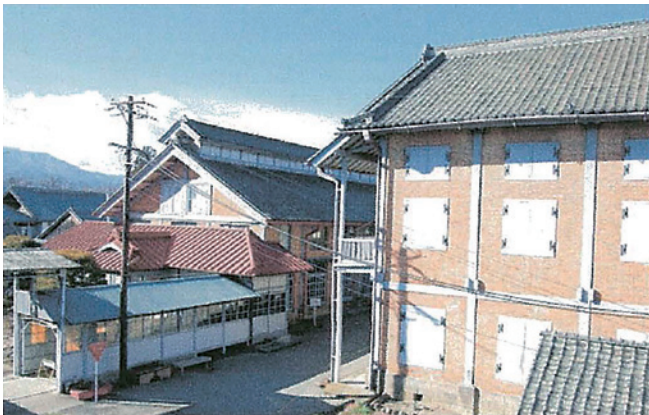
写真1 富岡製糸場(右側が東置積所、左側が繰糸所)
