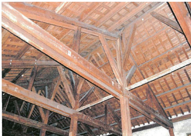
写真2 富岡製糸場(東置繭所の小屋組)
