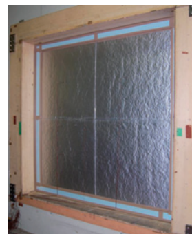
写真1 試験体取付状況 (試験体名:仕様㉓,室内側)
