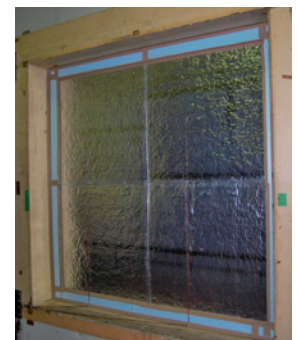
写真2 試験体取付状況 (試験体名:仕様㉔,室内側)
