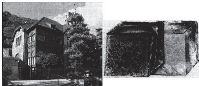
図3-1 G・トーマス邸とその屋根葺き材 葺き上がりの外観は45°傾いた正方形だが、重ね代があるので、実際の形状は右図のような六角形になる。
