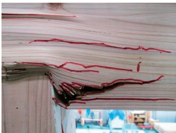
写真3 CLT壁柱の梁へのめり込み
