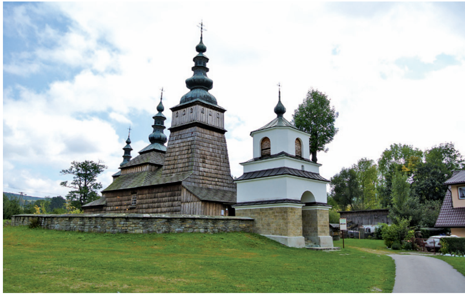
写真9 ポーランド オフチャリの教会 アプローチ廻り
