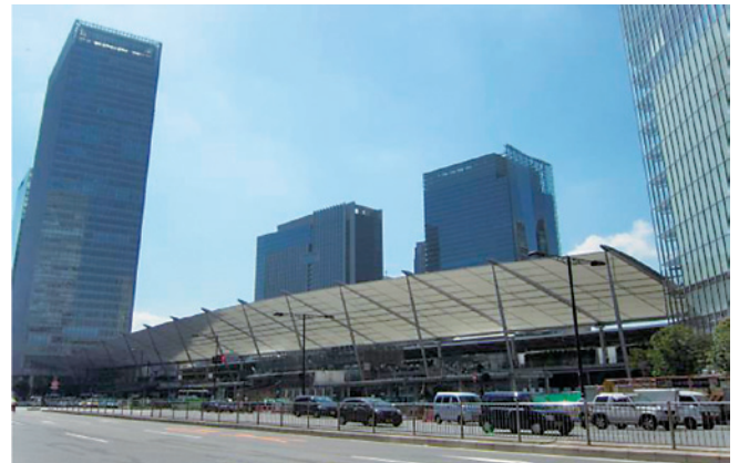
写真1 代表的な膜構造建築物 (東京駅八重洲口グランルーフ)
