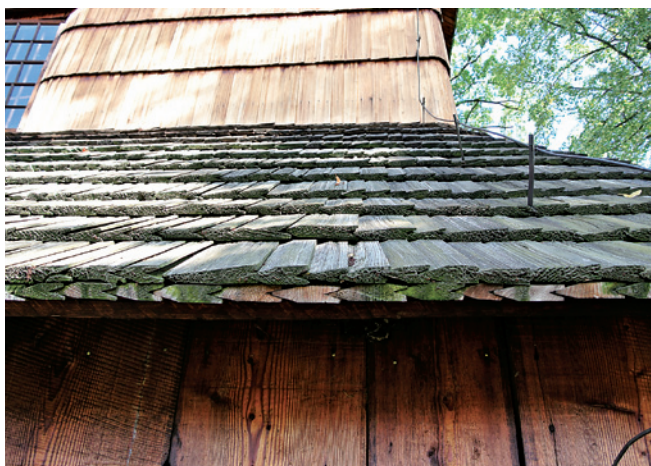
写真4 ポーランド デンプノの教会 屋根詳細
