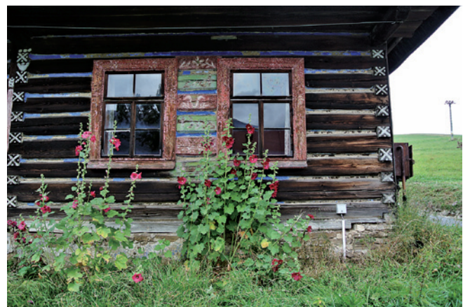
写真14 スロバキア ジュディアル集落 外壁詳細
