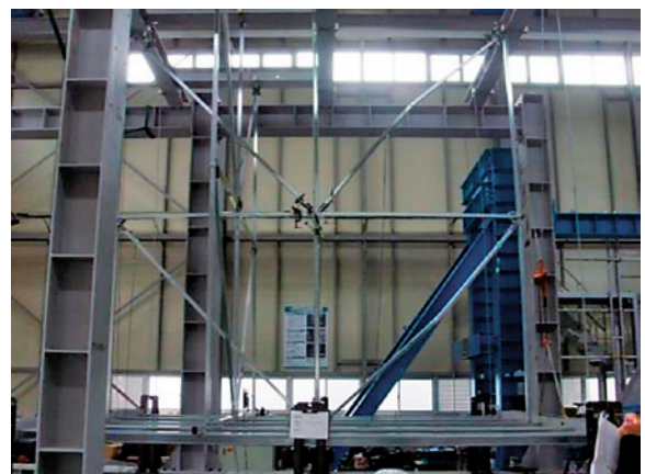
写真6 モデル7の終局状況(部材の座屈)
