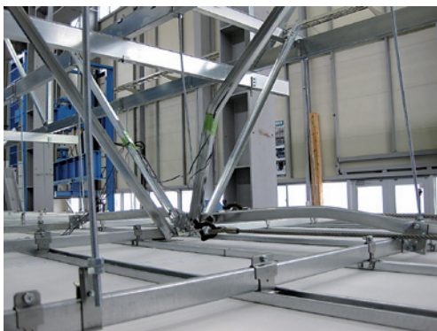
写真13 破壊状況 試験体記号：耐震スマート天井①+在来天井(SCS-063,064) 斜め補強材及び野縁受けの変形
