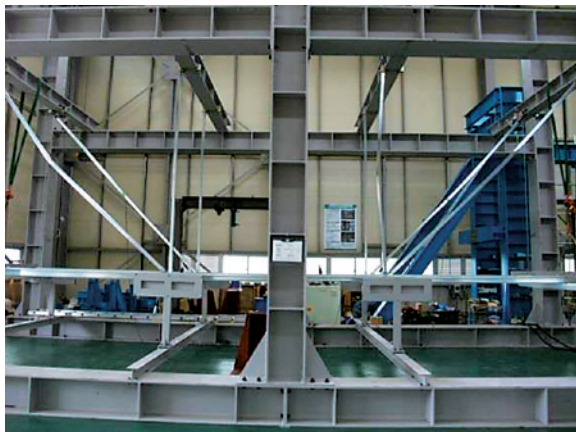
写真3 モデル1の終局状況(部材の座屈)
