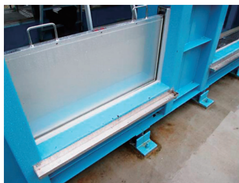
写真3 浸水防止性能を有する止水板
