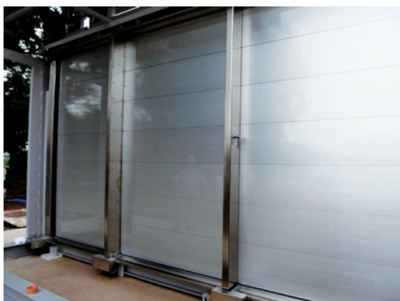
写真2 浸水防止性能を有するシャッター
