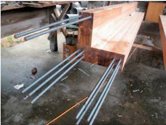
L形断面柱の柱脚
