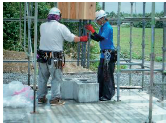
L形柱の柱脚のRC基礎への挿入作業
