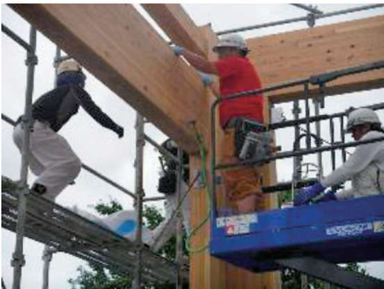
桁梁と梁間大梁および柱の接合
