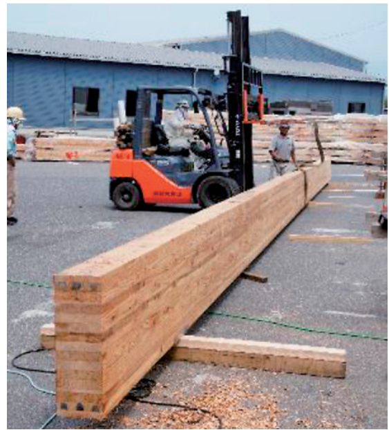
18.4mの大梁の運搬
