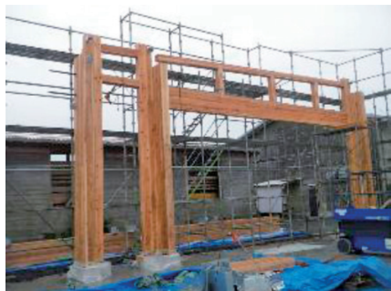
桁組の建て方
