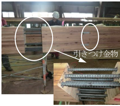
写真3 実大での継ぎ手の接合作業
