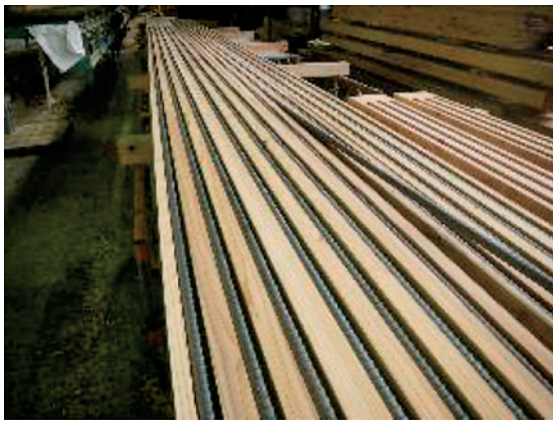
19mのラミナに3-D25鉄筋を挿入
