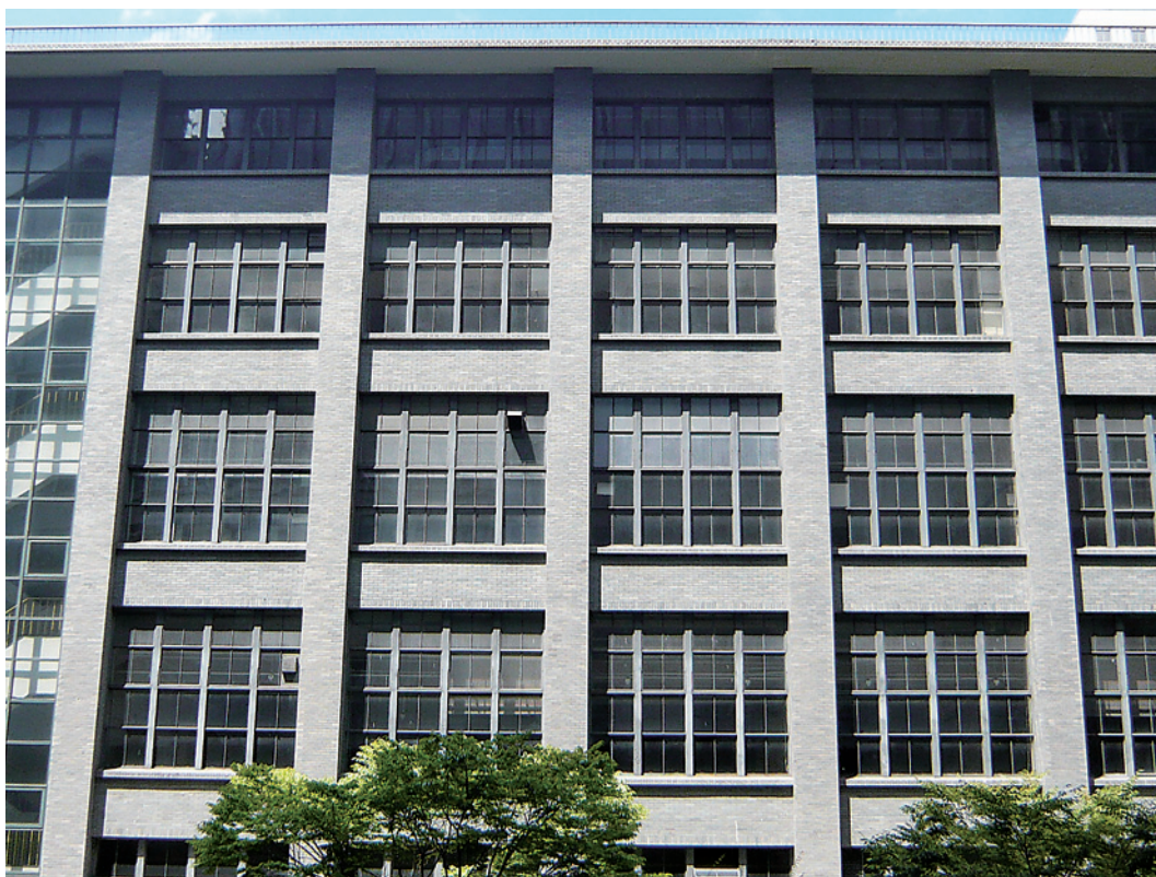
写真3 旧大阪中央郵便局 南側 立面詳細
