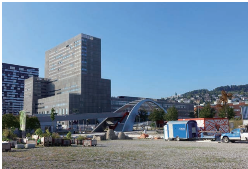
写真8 チューリッヒ、元乳製品工場をチューリッヒ大学の芸術系学部等に改修 外観
