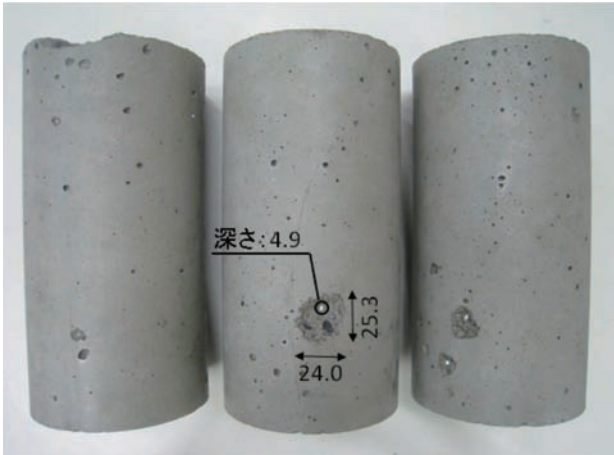
写真3 コンクリート供試体に発生するポップアウトの一例
