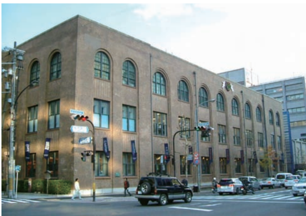
写真12 京都市、新風館。1926年竣工、吉田鉄郎設計の電話交換局を2001年、商業施設に用途転用して活用されていたが、現在、旧庁舎部分の躯体を残して解体し、ホテル、商業施設などからなる複合施設に改修する工事が行われている。
