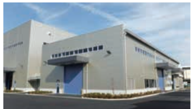
写真1 動風圧試験棟外観
