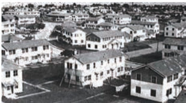
図5-4 塗装工事中の米軍施設
