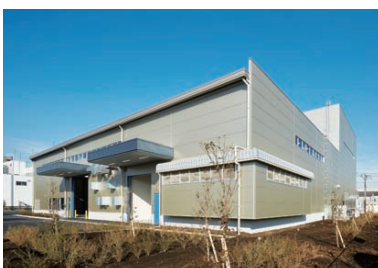
写真5 動風圧試験棟の外観
