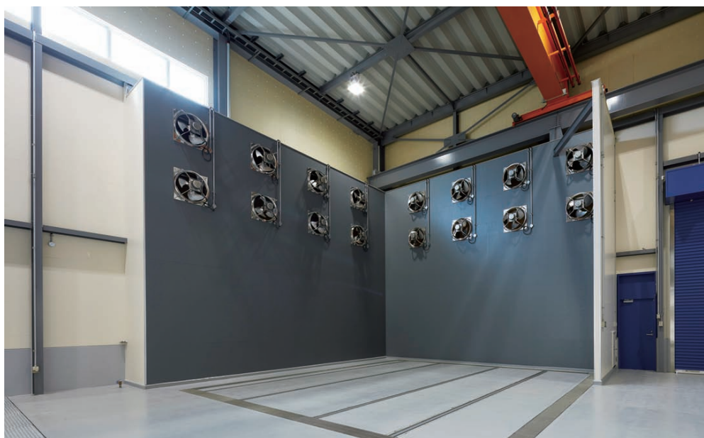
写真7 大型送風散水試験用排気ファン
