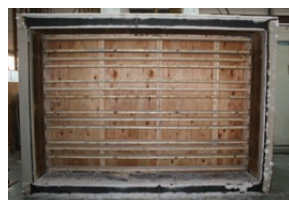
写真7 試験後の床根太の状況
