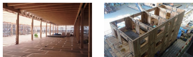
a) 軸組構造（集成材） b) 壁構造（CLT）
