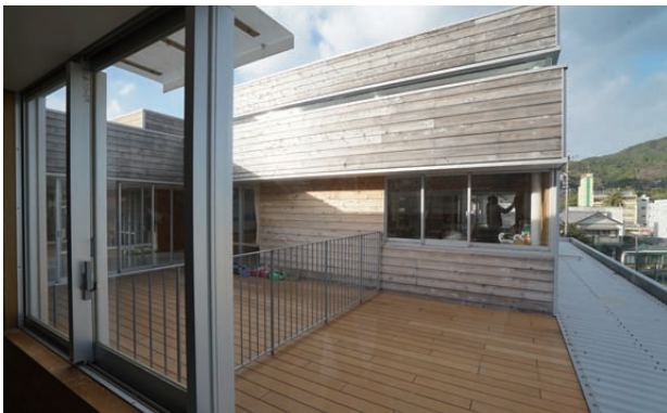
写真5 経年変化により光沢が増した木質外壁
