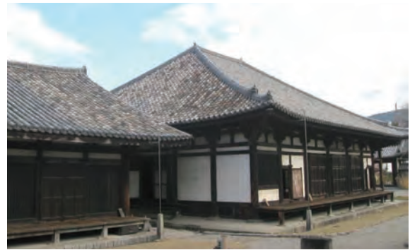
写真1 奈良・元興寺の瓦葺屋根
