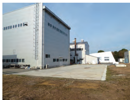
写真3 あと施工アンカー用の試験スペース
