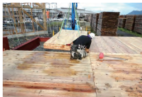
写真4 実大モックアップによる施工実験 (山佐木材下住工場にて)
