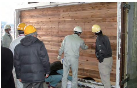
写真8 下面加熱試験後、耐火被覆を除去して 内部のCLTの状況を確認している様子
