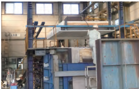
写真7 下面加熱試験の試験体設置の様子 (西日本試験所 水平炉)
