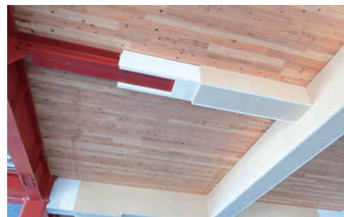
写真9 松尾建設本社ビルの床下面の 耐火被覆の施工の様子
