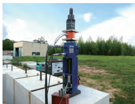
写真5 アンカーサイズM42の引張試験状況
