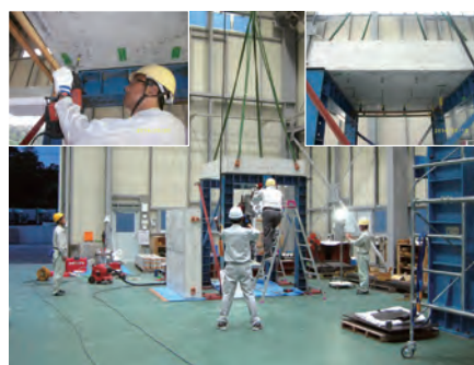
写真4 上向き施工時の状況
