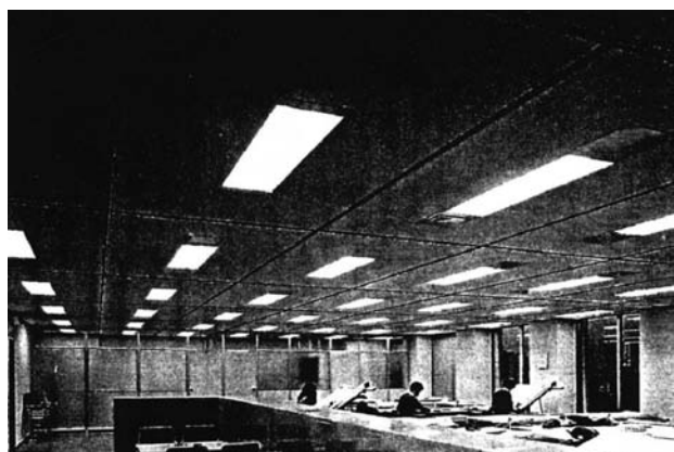
図8-5 パネル方式のシステム天井構法
