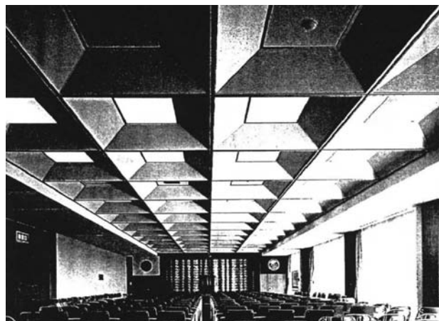
図8-7 クロス方式のシステム天井構法
