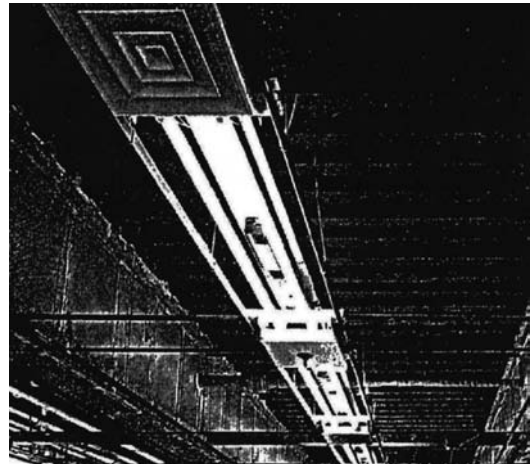
図8-3 設備機器先付け工法
