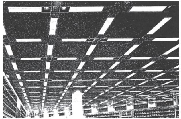
図8-9 グリッド方式のシステム天井の例
