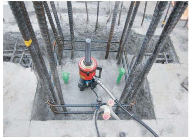
写真11 あと施工アンカーの引張試験状況
