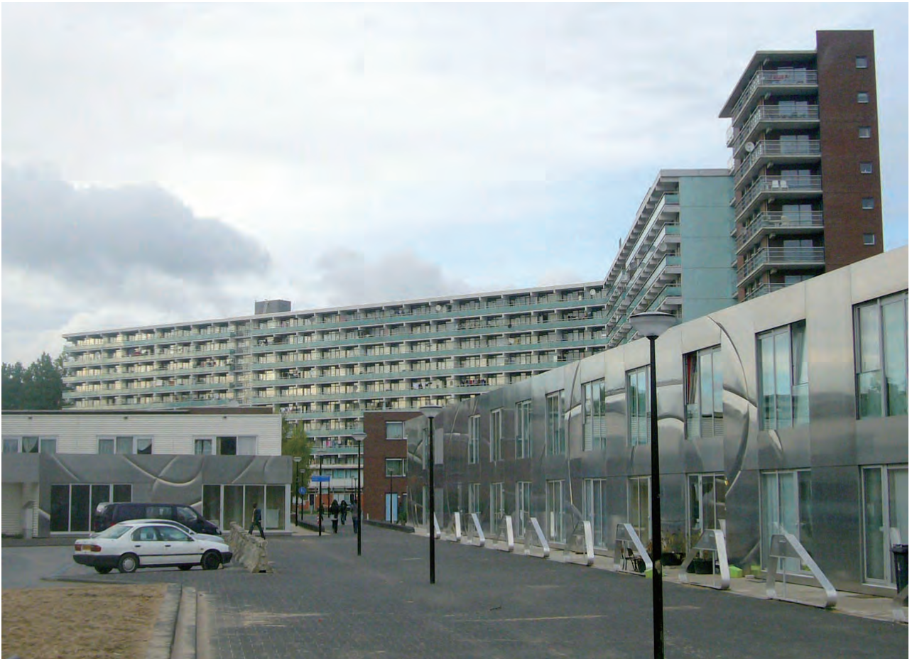
写真9 アムステルダム市郊外のベルマミア団地の再生 高層棟の約半分が解体され中低層棟に建替えられた
