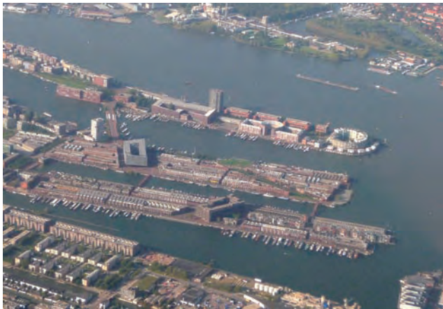
写真14 アムステルダム湾岸部に開発された新しい住宅地区
