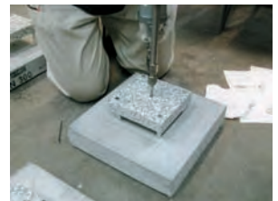
写真9 樹脂の注入状況
