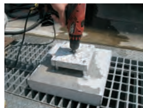
写真8 石材表面の孔の 仕上げ
