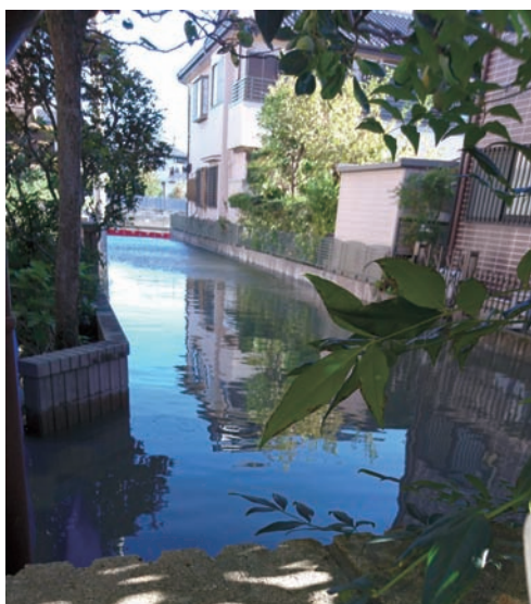
写真1 2019年台風19号による浸水被害(筆者撮影) (場所:埼玉県南埼玉郡、浸水高さ約50cm)
