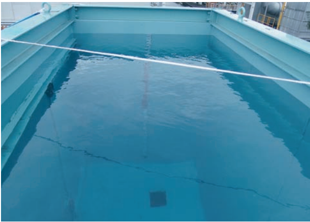
写真3 浸水防止性能試験及び耐水圧性能試験実施状況 (設定水位まで水を注した状態)
