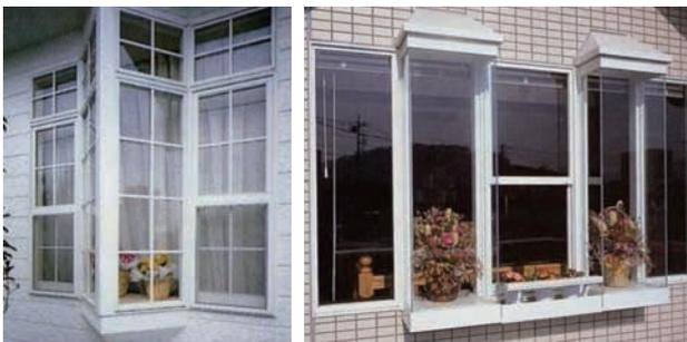
図11-18 様々な開閉方式の窓の組合せが可能なサッシ
