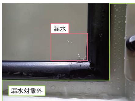
写真2 漏水状況(キャビネット扉裏面)
