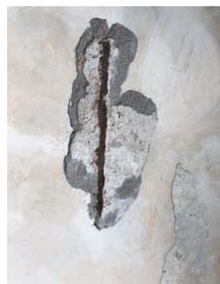
写真1 PCa造の現場打ち基礎部分のかぶり厚さ不足によるコンクリートのはく落
