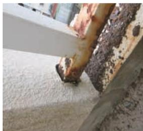
写真3 バルコニー一部の鉄製手すり(接合部)の劣化
