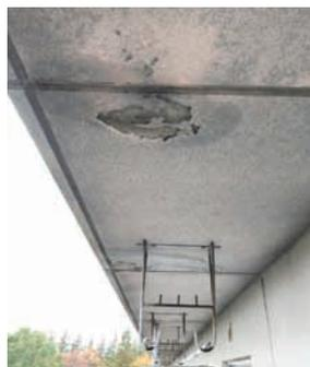
写真2 バルコニー一部分の防水の劣化による漏水と仕上げの脱落
