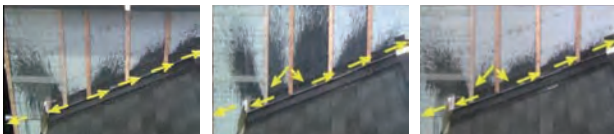
写真11 雨水浸入結果 (通気層上部構造:A) 実験時間5分 写真12 雨水浸入結果 (通気層上部構造:B) 実験時間30秒 写真13 雨水浸入結果 (通気層上部構造:C) 実験時間4分
