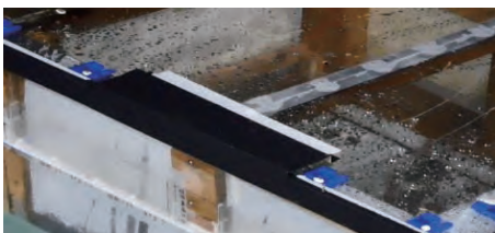
写真15 雨水浸入結果(野地板裏面の隙間、風速20m/s)
