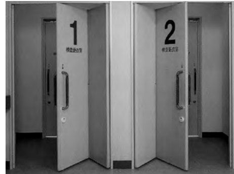
図15-4 『マルチオリド』 双方向型で、室内外の両方に戸が折れる機構 日本ファイリング建材、1997 (H09) 年
