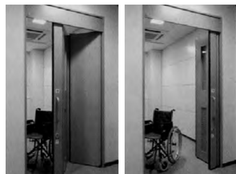
図15-5 上吊り式の変形折戸 引戸のような動作で開閉が可能である。
